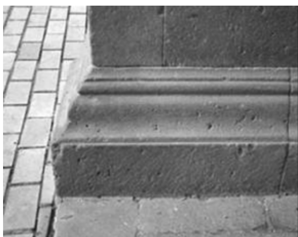
Actuaciones de restauración recientes. Cabrera Pinto.
