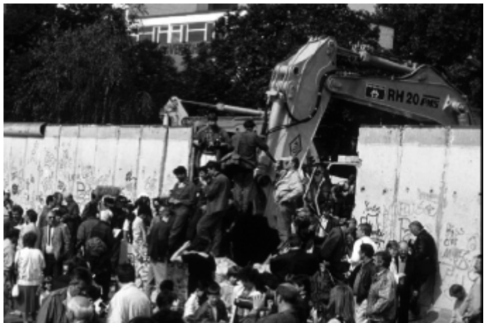
Demolición del muro, Junio 1990.
